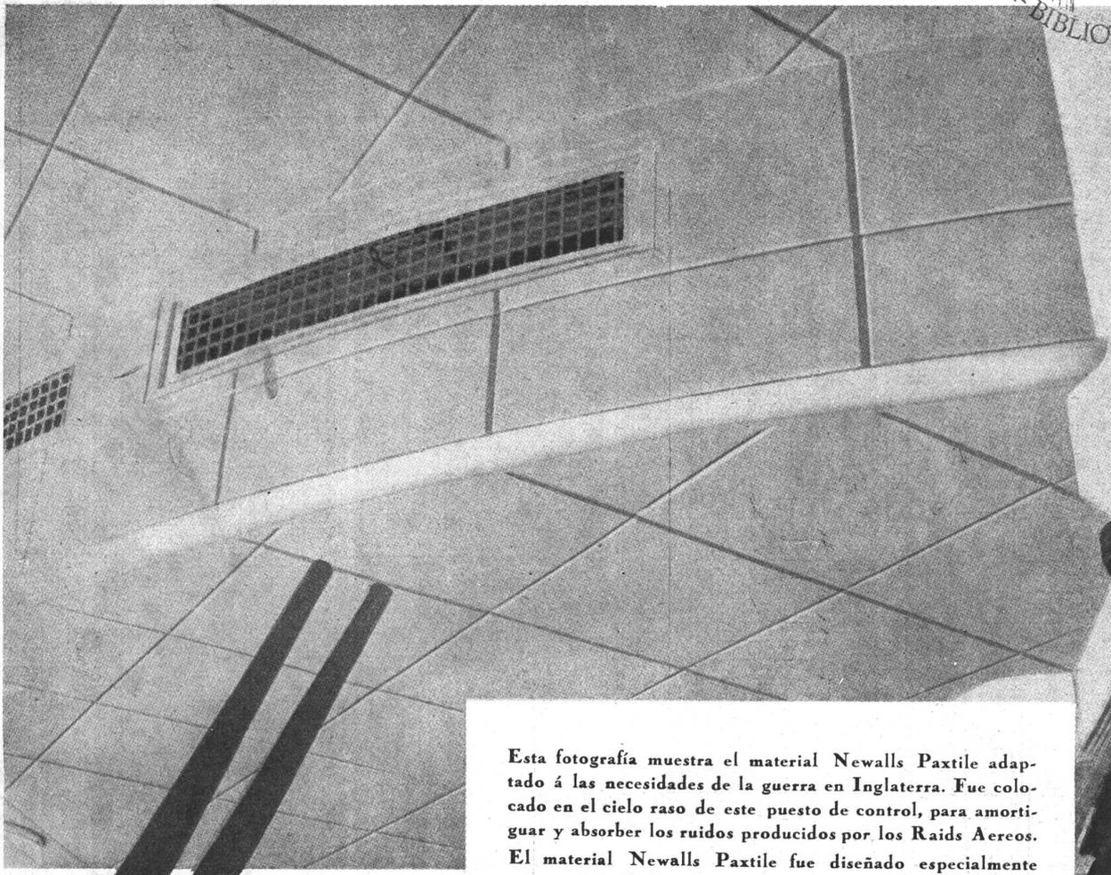
Esta fotografía muestra el material Newalls Paxtile adaptado á las necesidades de la guerra en Inglaterra. Fue colocado en el cielo raso de este puesto de control, para amortiguar y absorber los ruidos producidos por los Raids Aéreos.
