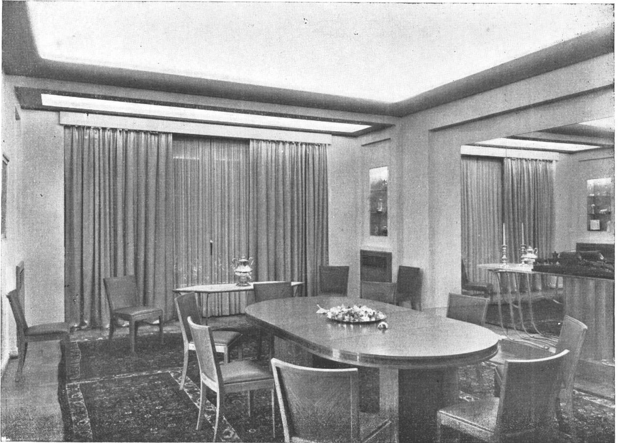
Fig. 3 — Comedor iluminado por una garganta luminosa y una franja de 0,39 de ancho
