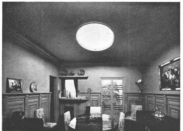
Fig. 5. — Iluminación de un comedor por medio de una cúpula luminosa de 1 metro de diámetro
