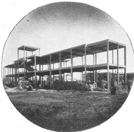
Un detalle de la estructura de hormigón del edificio del Hospital Arroyito, construido con cemento "SAN MARTIN"
