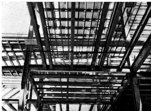
Serpentinas de calefacción armadas dentro del armazón metálico de una casa de escritorios
