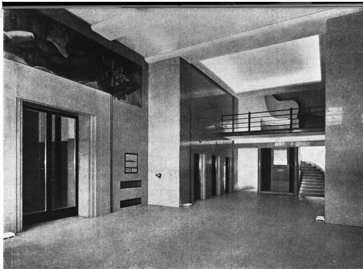
VISTA INTERIOR DEL GRAN «HALL» DE ENTRADA
