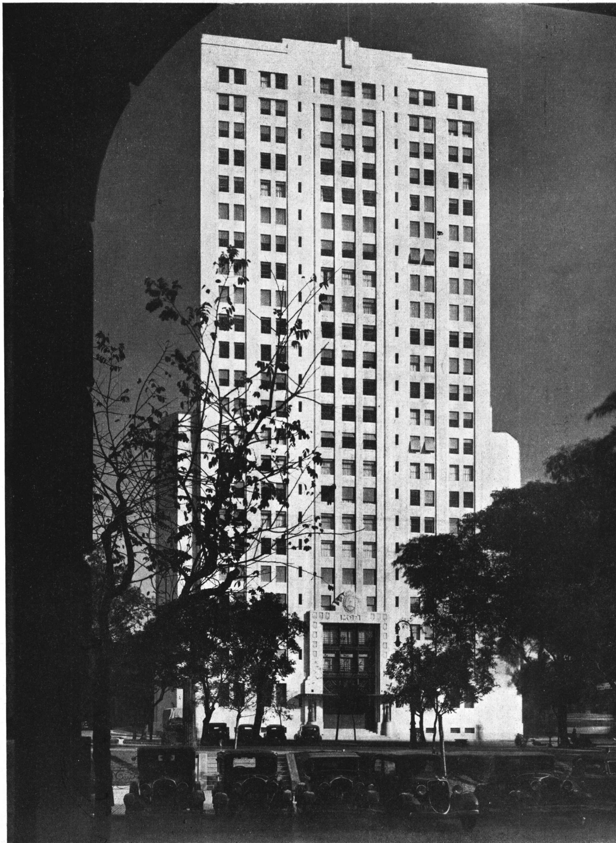
FACHADA sobre la Avenida 9 de Julio
