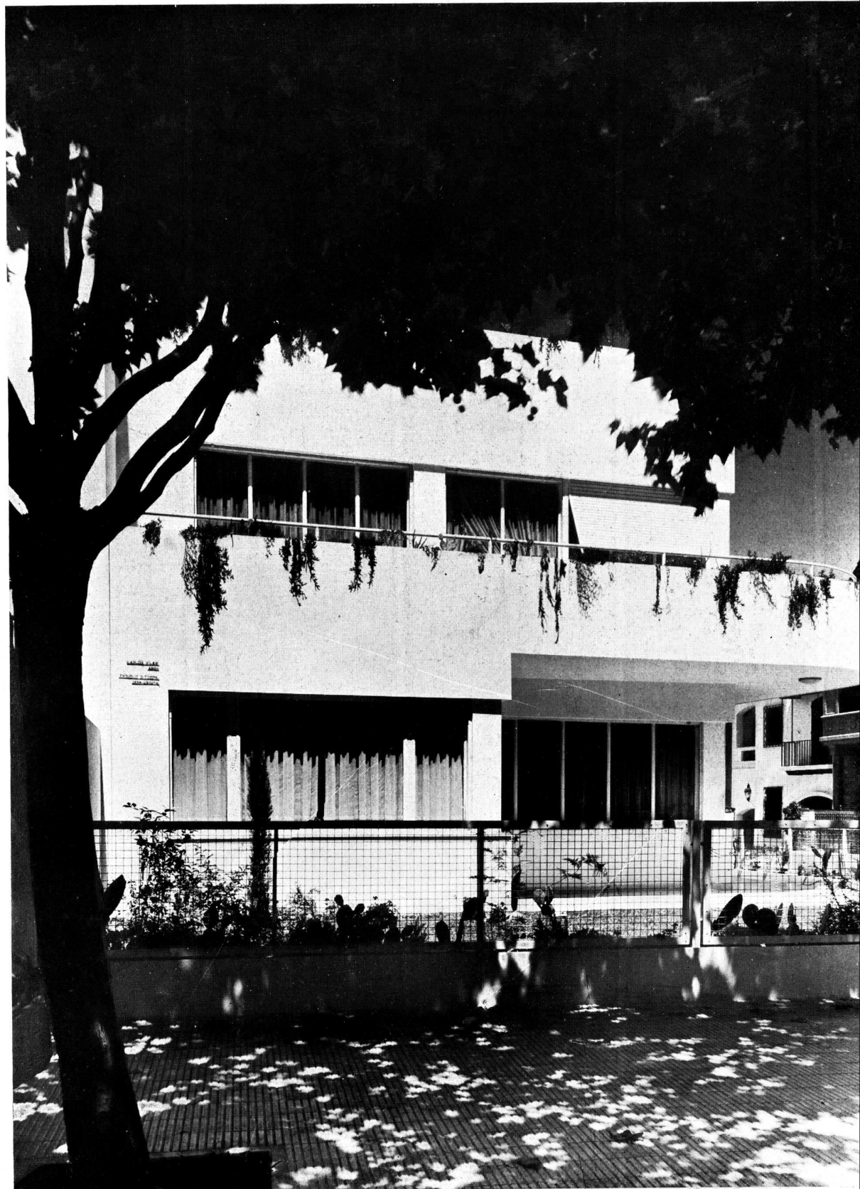
DETALLE DE FACHADA
