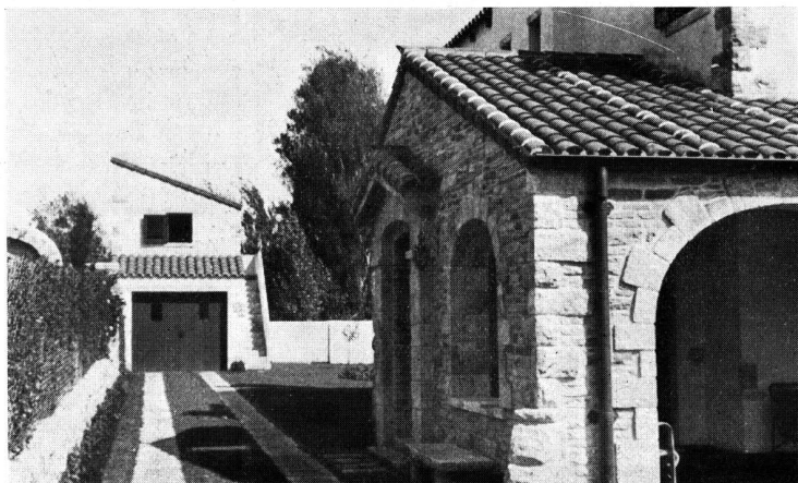
DETALLE DE ENTRADA AL GARAGE
