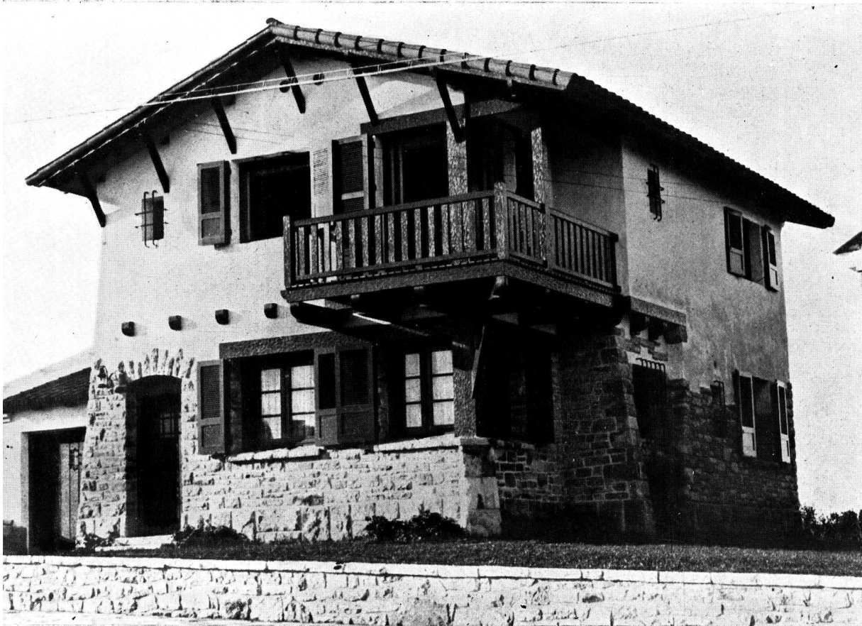
TERCER PREMIO - ARQUITECTO: LUIS JORGE FOURCADE Propiedad del señor José A. Fourcade - Calle Alberii 137 CONCURSO DE FACHADAS EN MAR DEL PLATA
