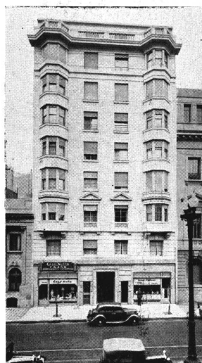
Edificio Santa Fe 1153 Arq. A. Gutiérrez y Urquijo
