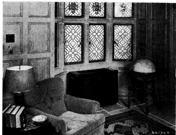
Ilustración gráfica de la instalación de un acondicionador de aire Westinghouse. El modelo ilustrado es adaptable tanto en invierno como en verano, suministrando indistintamente aire frío en verano y caliente en invierno.
