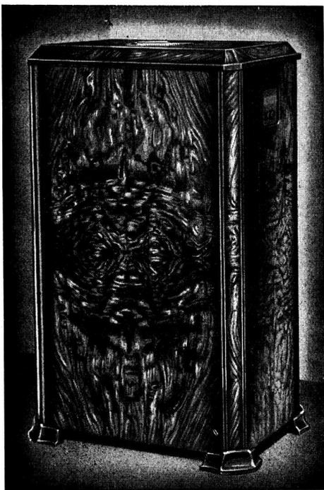
TEMPERADOR DE AIRE FRIGIDAIRE, MODELO SC - 75. *Uno de los numerosos modelos para la atemperación del aire en salas particulares, oficinas, departamentos, etc. No necesita conductos o cañerías. El gabinete es de acero.*
