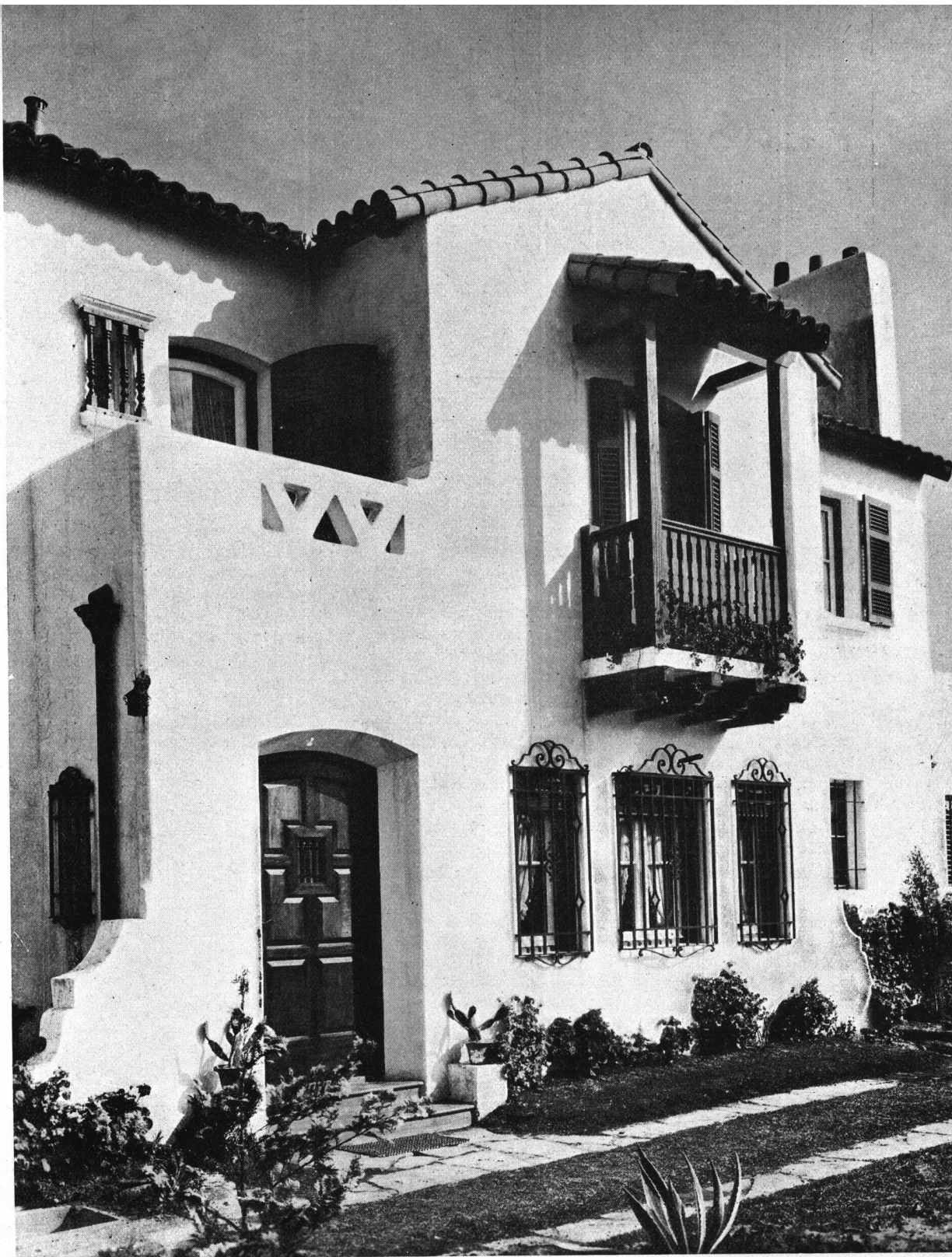
Detalle del frente y entrada principal
