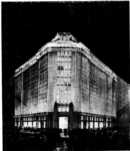
Instalación Central Nuevo edificio de la CHADE Diag. Norte Esmeralda y Cangallo
