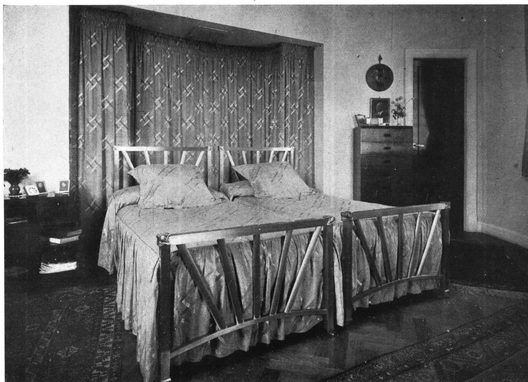
Vista de un dormitorio en el 8.º piso
