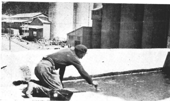
Silos de la fábrica cemento Minetti en Dumesnil Cubiertos con "DURSIT" - Empresa Constructora "GEOPE"
