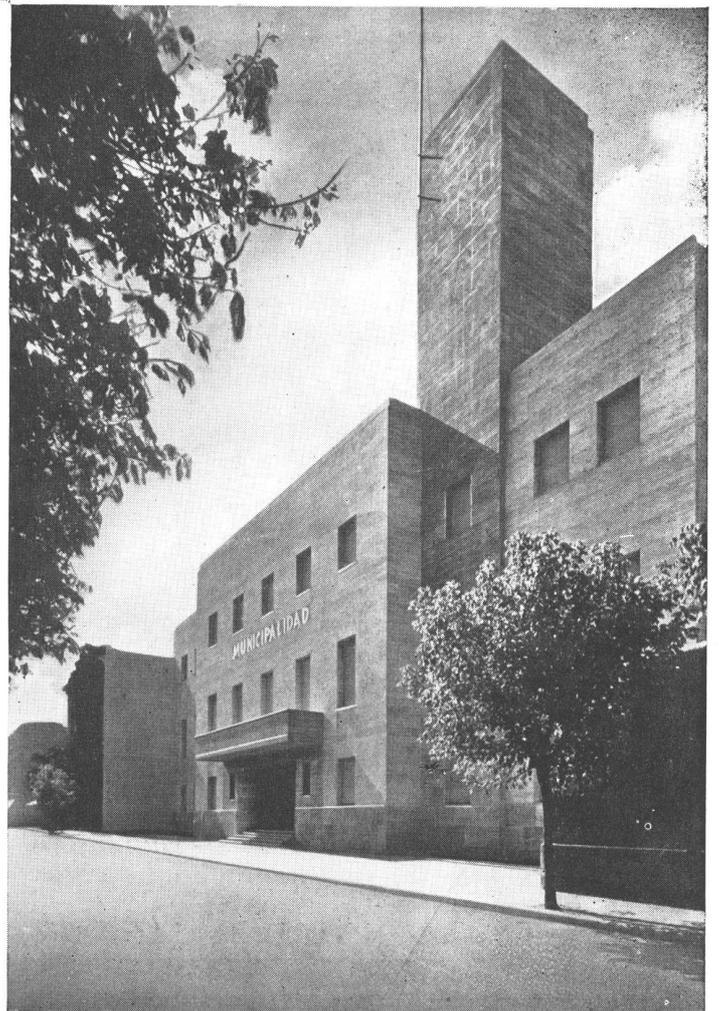
Un aspecto del frente del edificio en el que se observa la torre de hormigón dentro de la cual se ha construido un tanque, también de hormigón, cuya capacidad es para 40.000 litros de agua
