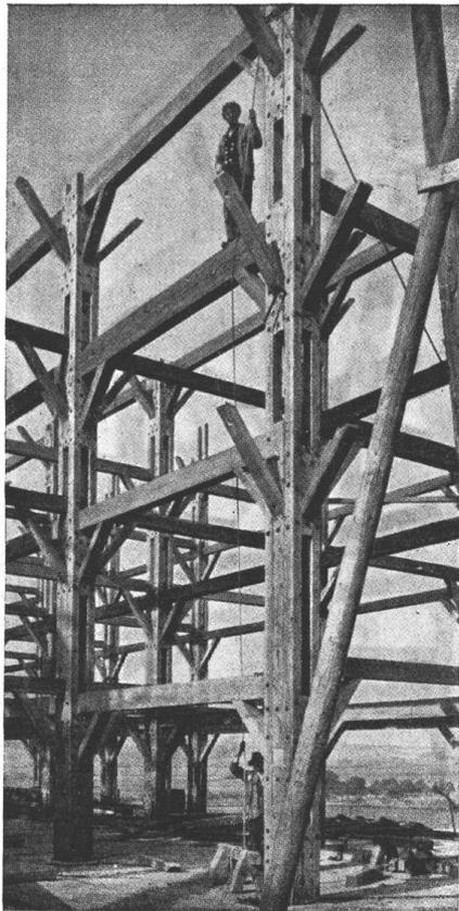
El mismo tipo de construcción mostrado en la figura anterior, pero realizado en un edificio moderno. Fácil es advertir el notable parecido con una estructura de hormigón armado.
