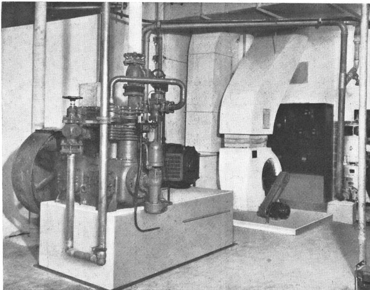
ING. DOMINGO L. BIANCHI. Cine Teatro Normandie. Corte longitudinal y abajo el equipo de acondicionamiento de aire instalado por Carrier Lix Klett S. A.
