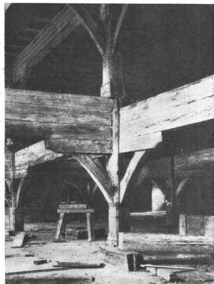
Esqueleto del sistema "bundbau" (construcción ligada.)
