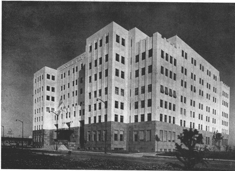
La instalación eléctrica de luz y fuerza motriz en el nuevo edificio de los F. F. C. C. del Estado fué ejecutada totalmente por la casa "SIEMENS"
