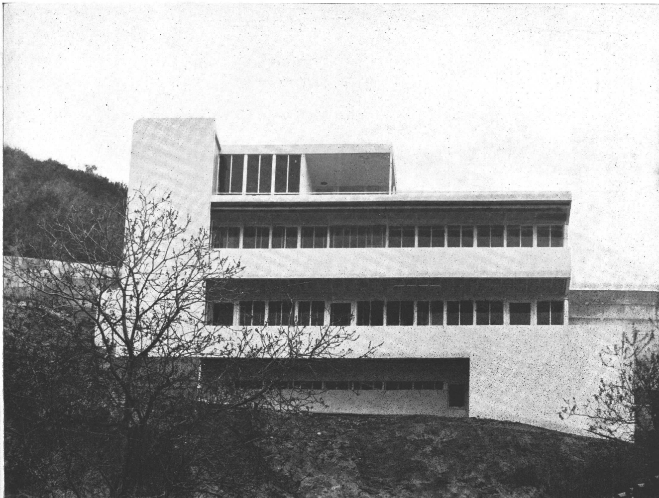
Vista de la casa eléctrica desde abajo.
