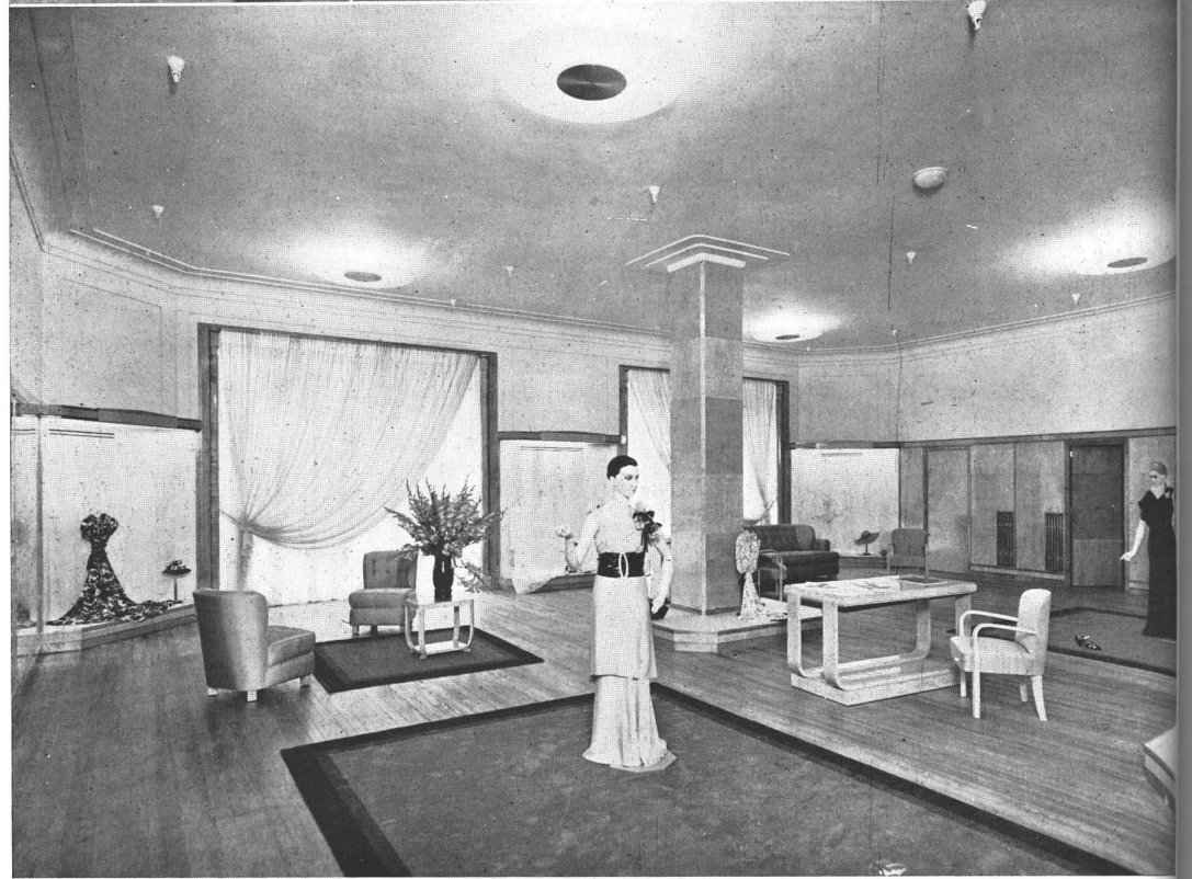
Modernización en la Casa Harrods. ARRIBA, una vista parcial del Salón de modelos. Los revestimientos de columnas y paredes son de madera enchapada con maple adamascado y las bases y plataformas de exposición en sicomoro blanco lustrado natural. ABAJO, otra vista del Salón de modelos mostrando los grandes ventanales que dan sobre la calle Paraguay.
