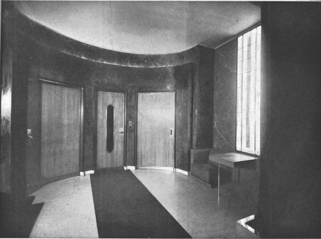
ARQS. LAMARCA Y BLAGOVESTCHENSKY. Casa de departamentos. ARRIBA, detalle de la entrada. Revestimiento de granito pulido y mármol verde Balcarce. Puerta de entrada de acero inoxidable, opalina negra y cristal. ABAJO: Vestibulo de entrada con las puertas de acceso a la Porteria, ascensor principal y escalera de servicio. Iluminación indirecta.
