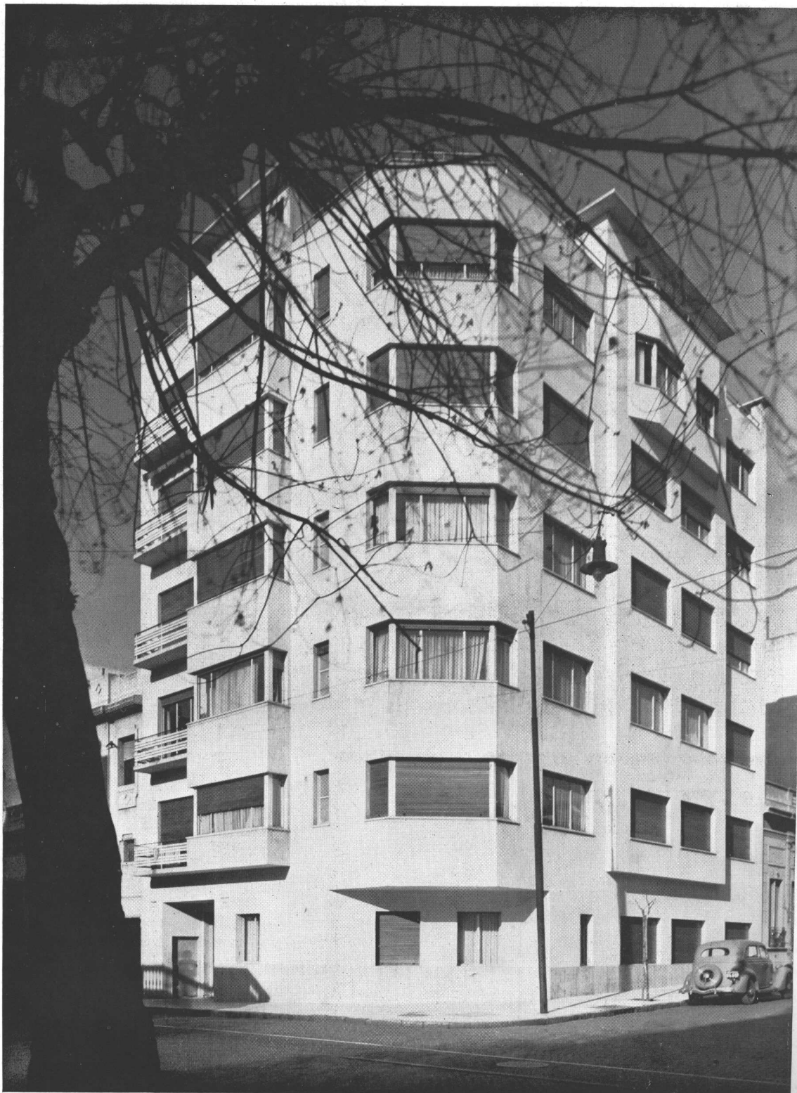
ARQS. O'FARRELL Y VILLEGAS. Casa de renta propiedad del Sr. Uriel O'Farrell. La fachada sobre las calles Junín y Peña.
