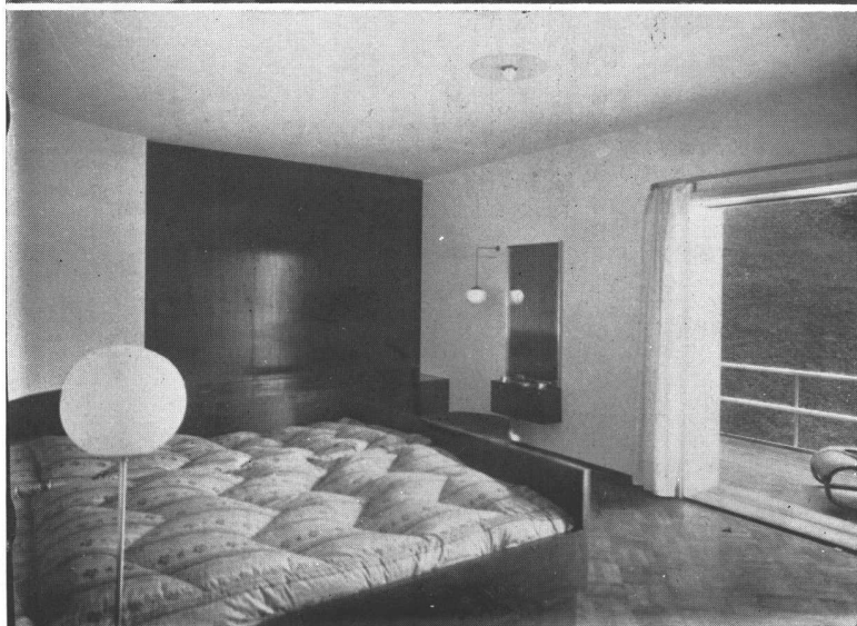
ARQ. LUIS WELZENBACHER, INNSBRUCK. Casa a orillas del lago Zell. - ARRIBA, la habitación de los niños. AL MEDIO, el cuarto de huéspedes. ABAJO, el dormitorio de la señora.
