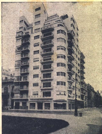
MONTEVIDEO Y JUNCAL Prop. A. Corsetti 21 baños de color Arq. A. Besio
