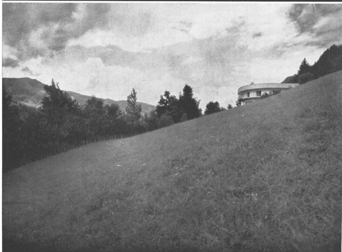
ARQ. LUIS WELZENBACHER, INNSBRUCK. Casa a orillas del lago Zell, ubicada en un inmenso prado. Al fondo los montes de Tennen. Delante de las habitaciones del piso bajo hay una terraza libre; delante de los dormitorios, un balcón corrido. La cornisa es el frente del espacio aislado debajo del techo.
