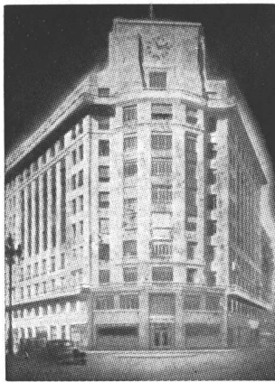
Edificio "Shell-Mex" Diagonal Norte y Esmeralda
