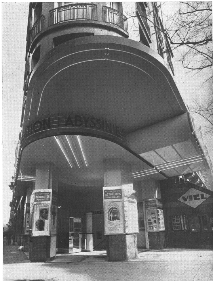
ARQS. MONTAUT Y GORSKA. El Teatro Cinintran. Una vista del exterior mostrando la boletería y las escaleras que conducen abajo
