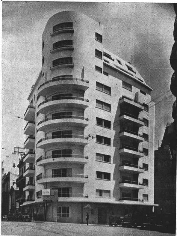
Obra Minner. Arq. Jorge Kalnay Pasamanos de todos los balcones en ANTICORODAL (Ejecutado conjuntamente con Estab. Klöckner S. A.)
