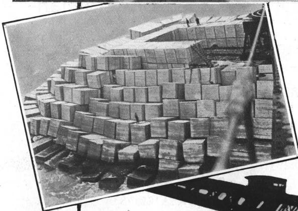
*Morro de la escollera Sur en la que se aprecia el tamaño de los blocks de hormigón. Base de la escollera: 100 m. altura: 20 m.*
