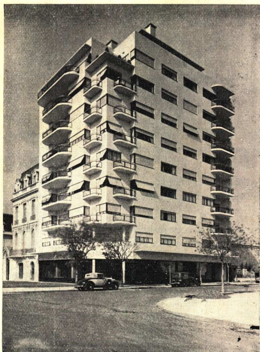
Vista del frente de la obra Avda. Alvear y Malabia
