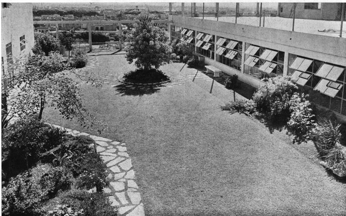
Vista general del roof-garden construido en la azotea de la Manufactura Algodonera Argentina
