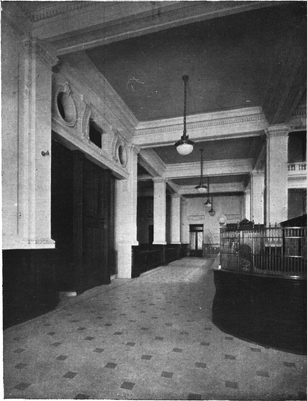
PARTE LATERAL DEL SALON DEL PISO BAJO. PROPIEDAD DEL BANCO DE GALICIA Y BUENOS AIRES. ARQUITEC- TO: V. COLMEGNA. S. C. DE A.
