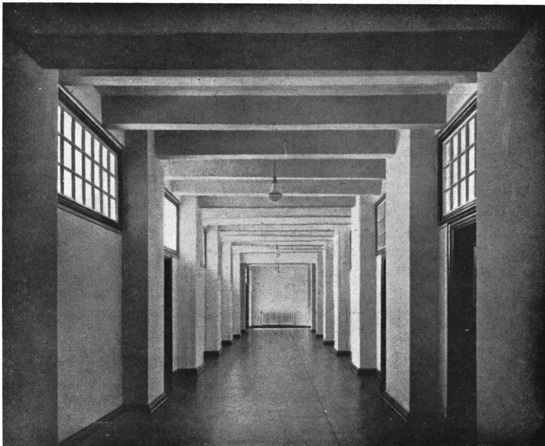
Vista del corredor central
