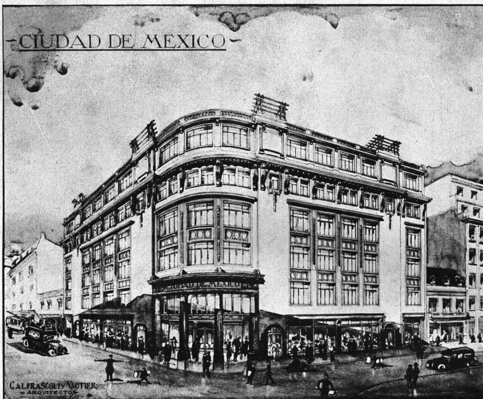
Nuevo edificio de la tienda « A la Ciudad de Mérico » — Sarmiento y Florida Arquitectos: Galfrascoli y Vautier
