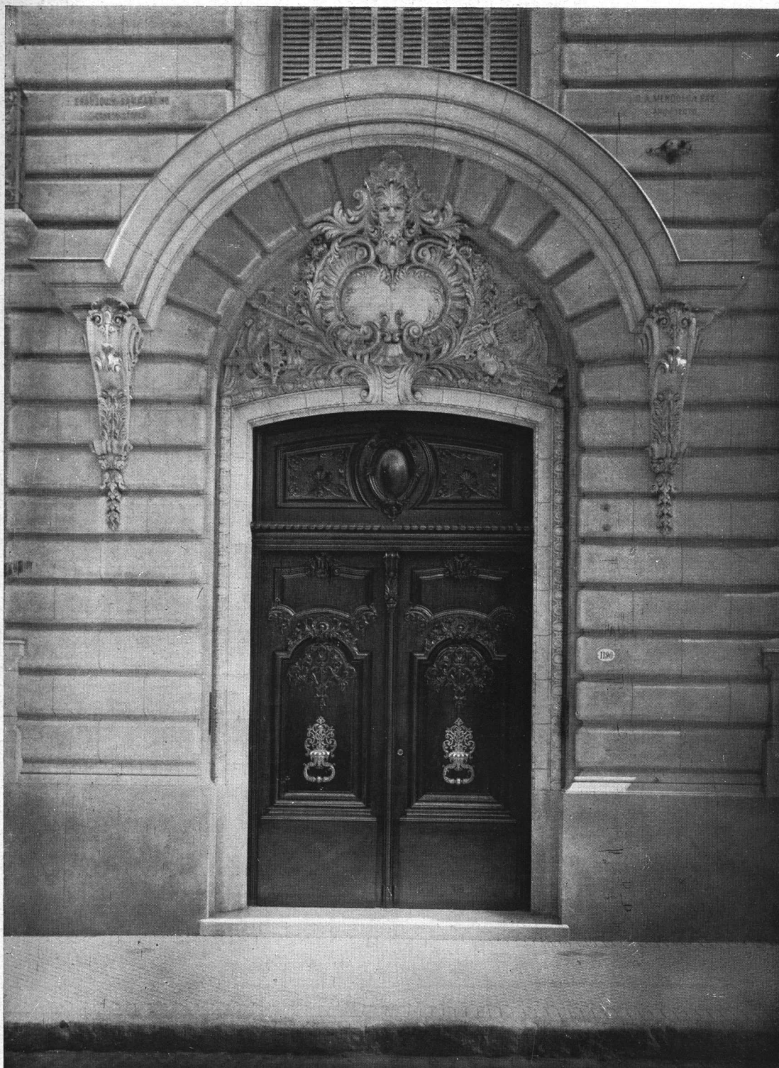
Puerta de calle
