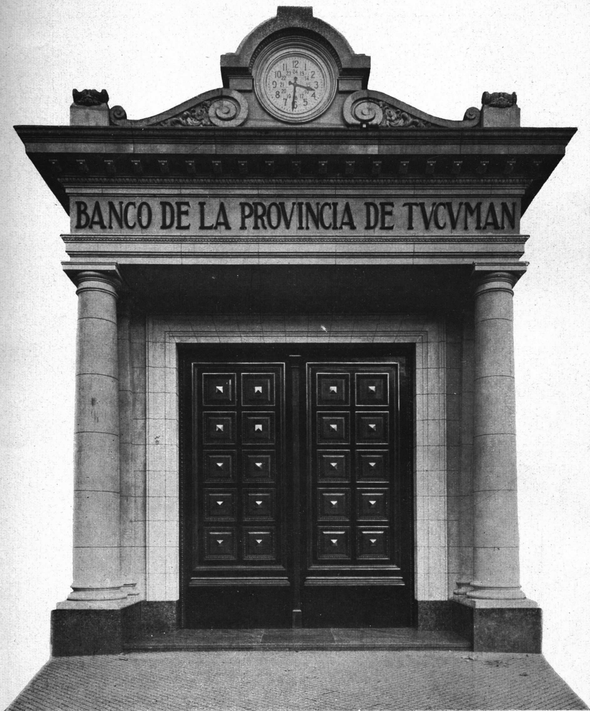
Puerta de calle
