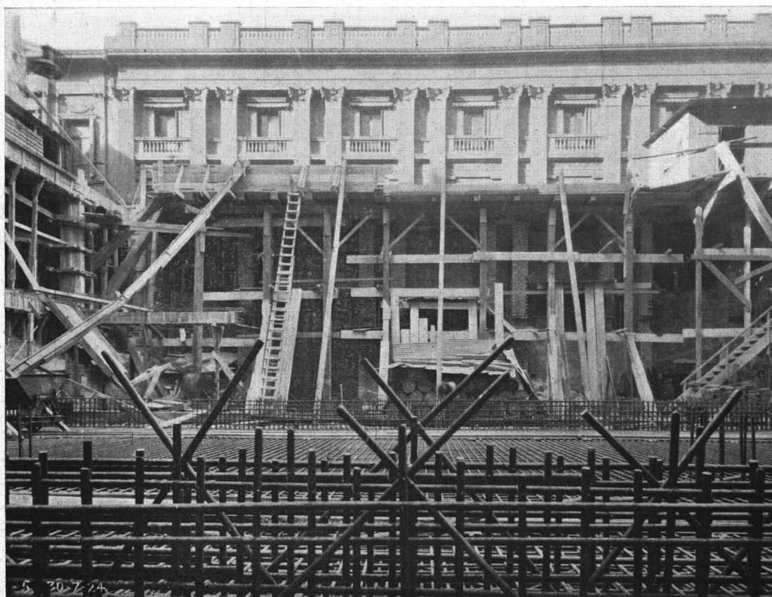
Vista de las Armaduras de los muros del tesoro.
