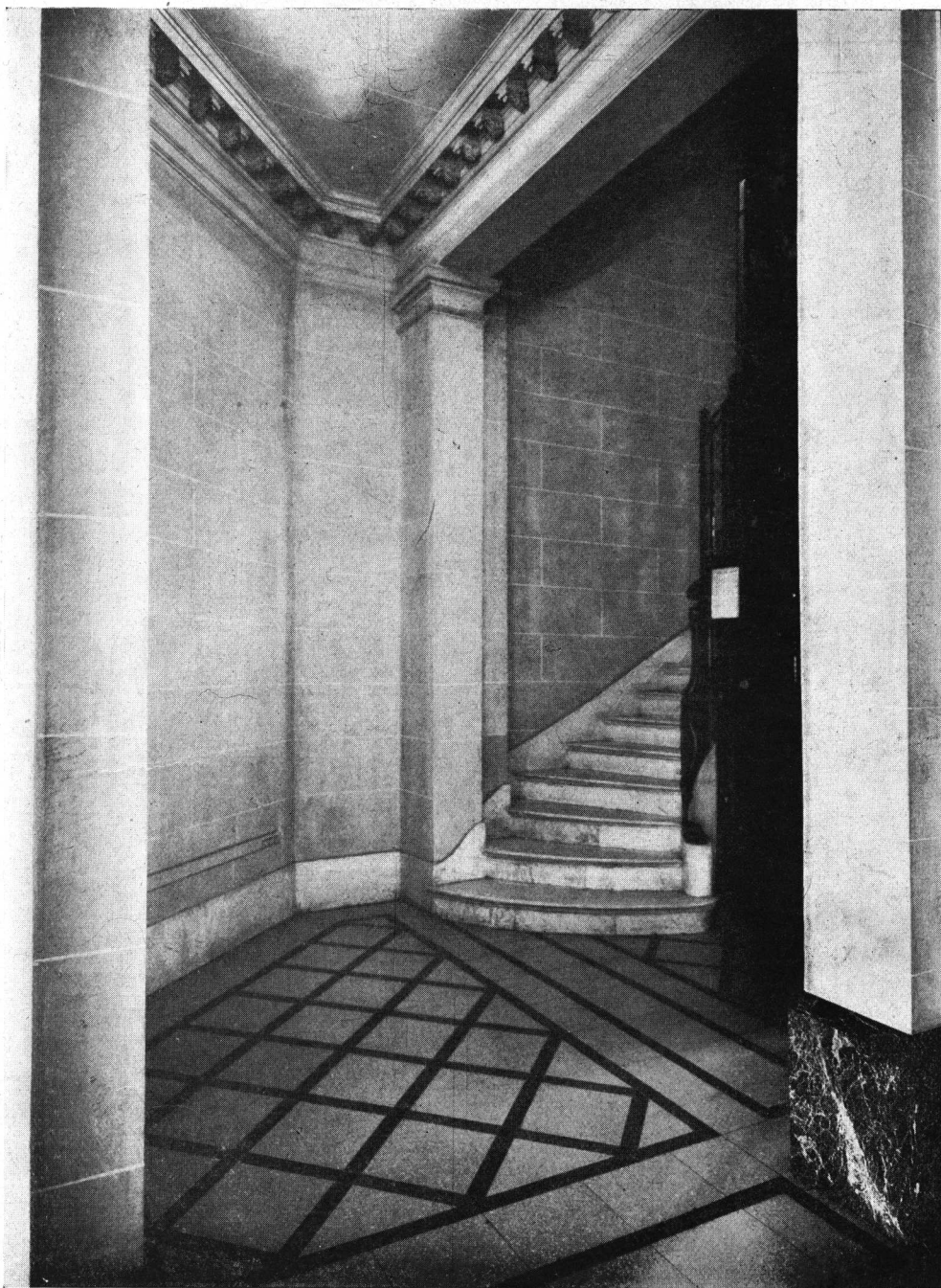
Arranque de la escalera
