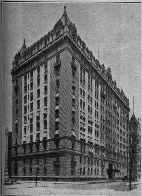
FIG. 74. — Casa de apartamentos The Langham. — Central Park Nueva York.
