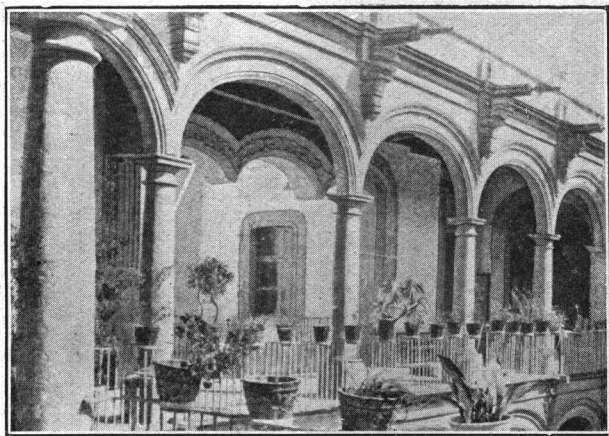
CORREDOR DE LA PLANTA ALTA DE LA CASA DE LOS CONDES DE SANTIAGO
