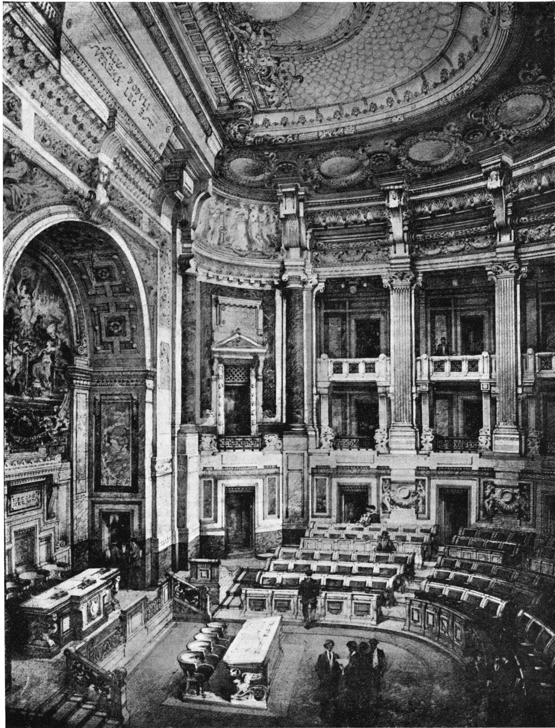
Vista del interior de la Sala de Sesiones
