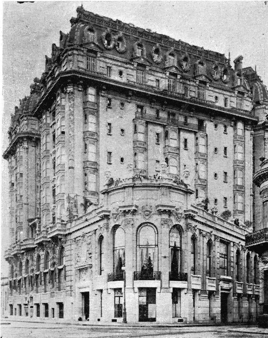
Vista perspectiva del edificio con las obras de ampliación terminadas
