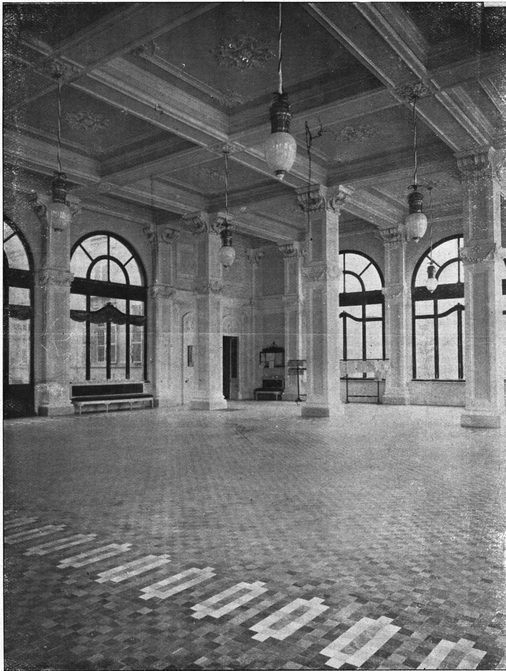
GRAN SALÓN DE LA BOLSA DE TURIN (Italia) — Construido de hormigón armado
