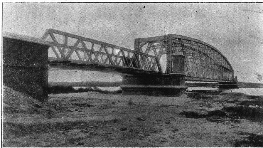
Puente sobre el Río Salado : (Tramo central de 100 m. de luz)
