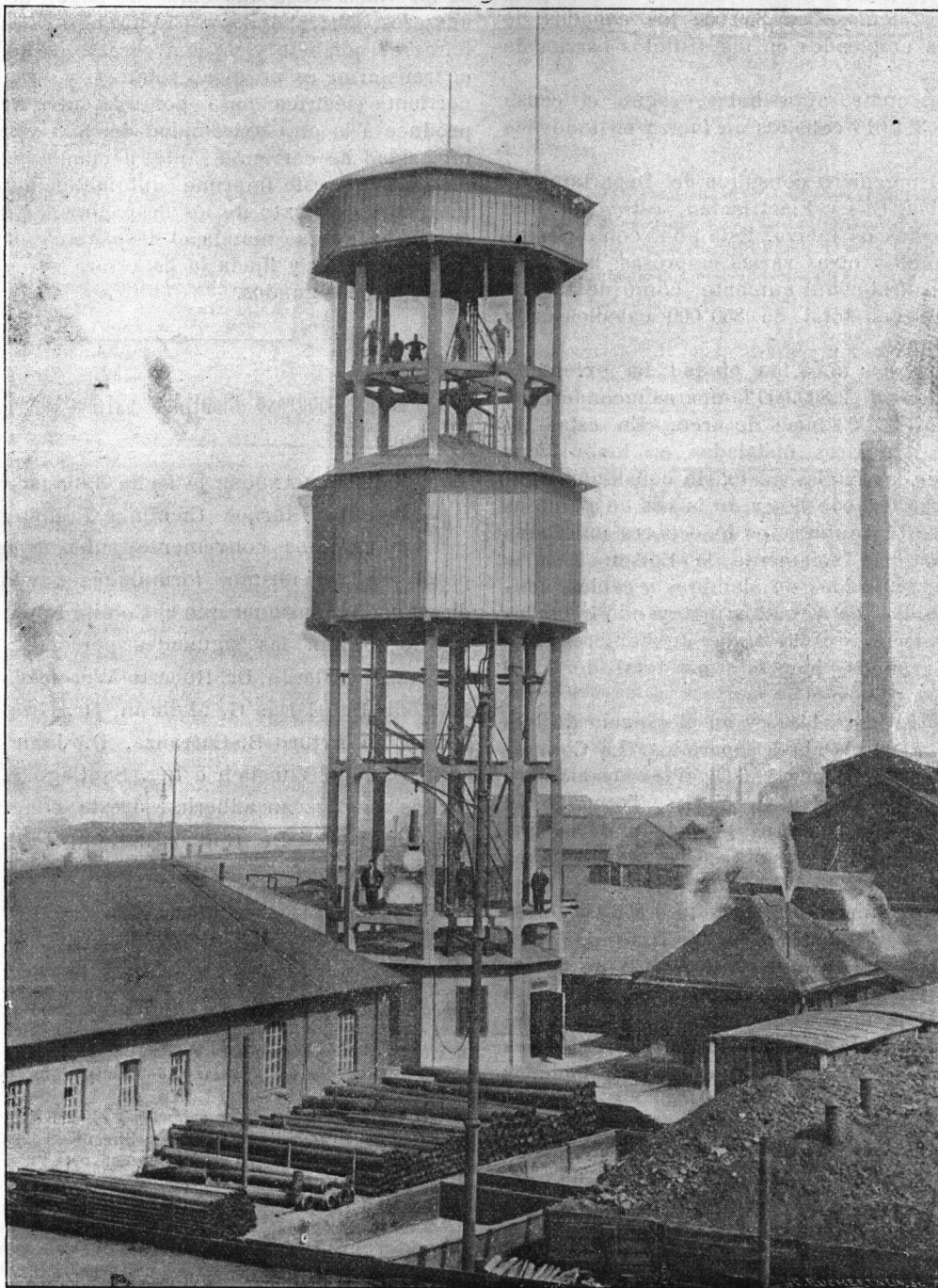
Fig. 2 — TORRE Y TANQUES DE HORMIGÓN ARMADO — (Ekaterinoslaw : Rusia )
