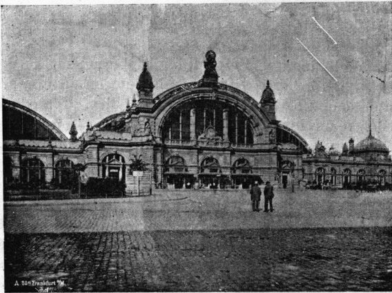
(Fig. 2) Estación de Frankfurt (Alemania)
