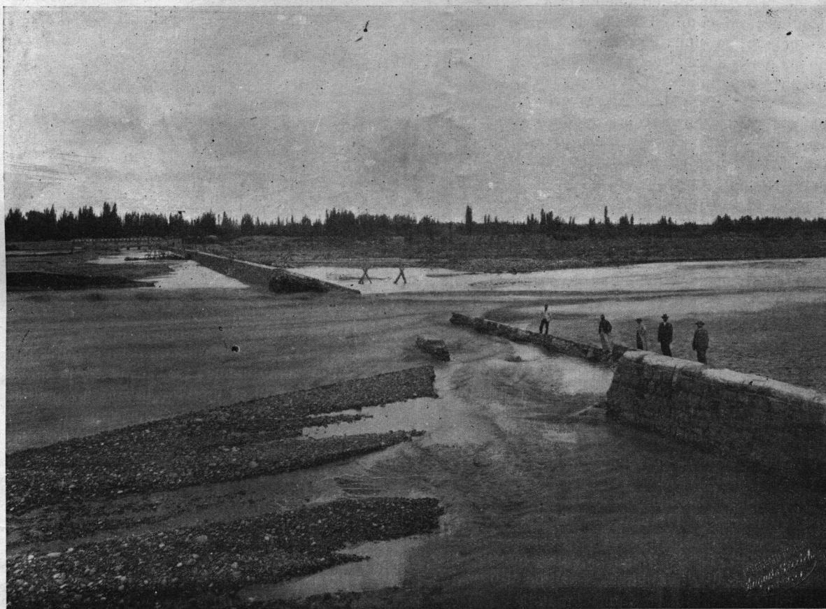
Fig. 2: Parte destruida del dique nivelador de Mendoza vista desde aguas abajo.
