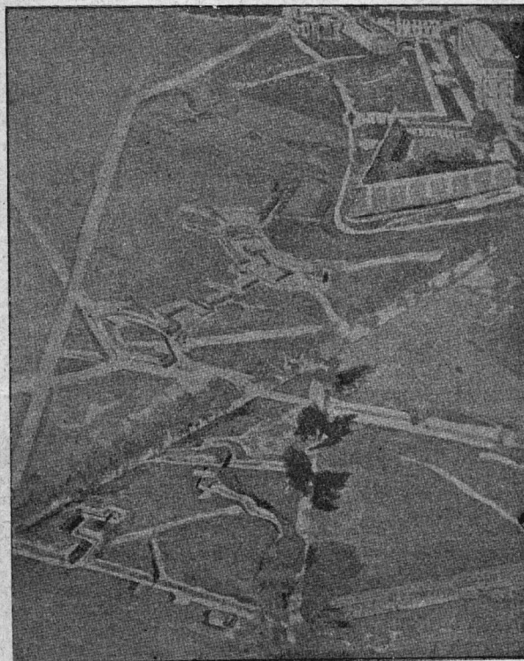
APERTURA DE TRINCHERAS EN ZAPA PROFUNDA
