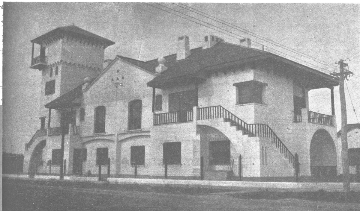
Uno de los pabellones construidos. Cada pabellón comprende ocho viviendas.
