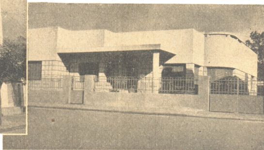
Casa para familia. - CAÑADA ROSQUIN - Santa Fe. - Propietario: Sr. Francisco Crossetti Saluzzo. - Construc- tores y Hormigón: Sres. Molinaro Manganelli y Cia.
