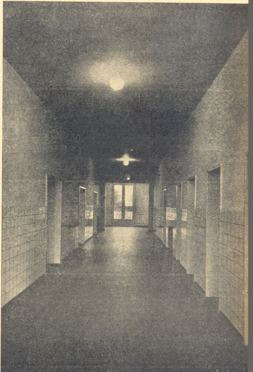
Galería principal del mismo Pabellón
