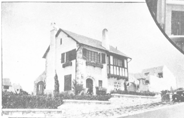
En las calles Rawson y A. del Valle, se levanta el chalet que muestra la fotografía, propiedad del Sr. Carlos Grether. Fué proyectado por los Arqs. Sres. Aberastain Oro y Dudley y construído por los Sres. Sautora e Hijos.
