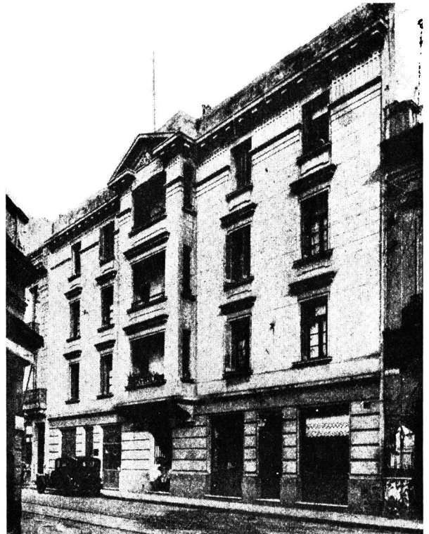
Casa Colectiva Bernardino Rivadavia, situada en la calle Defensa 767, entre las de Independencia y Chile, habilitada en marzo de 1922. Consta de 41 departamentos y 2 locales para comercio. Los departamentos tienen 2 y 3 habitaciones, vestíbulo, baño, cocina, con un total de 99 habitaciones. La superficie edificada es de 4.146,75 metros cuadrados. Los precios de locación son de $ 50 y 60 mensuales.
