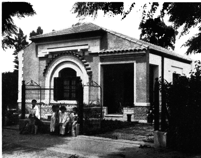
CHALET DE LA SR.ª CAROLINA H. DE PEZZALI
