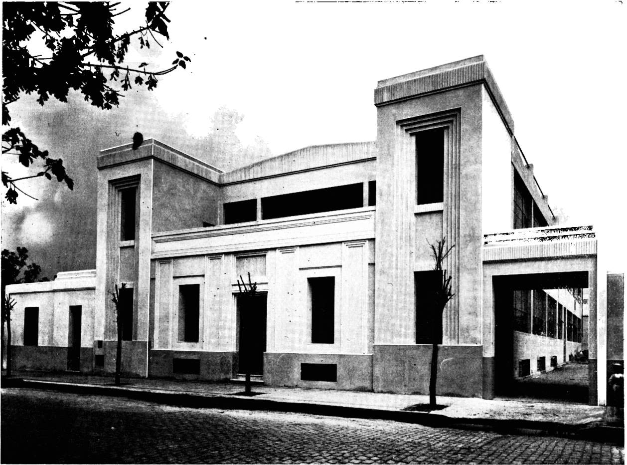
EDIFICIO INDUSTRIAL, CAMARGO 960 - 76
