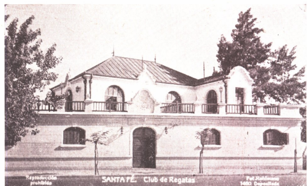
Cuerpo de edificio ya terminado
