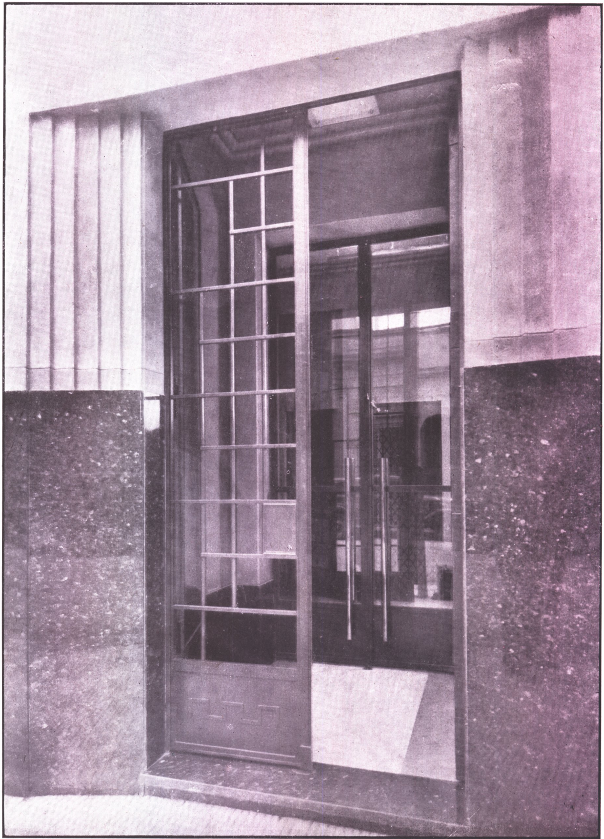
Puerta de calle
