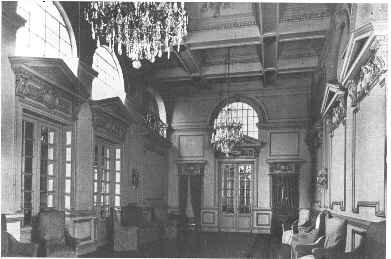
Dos aspectos del Salón de fiestas
