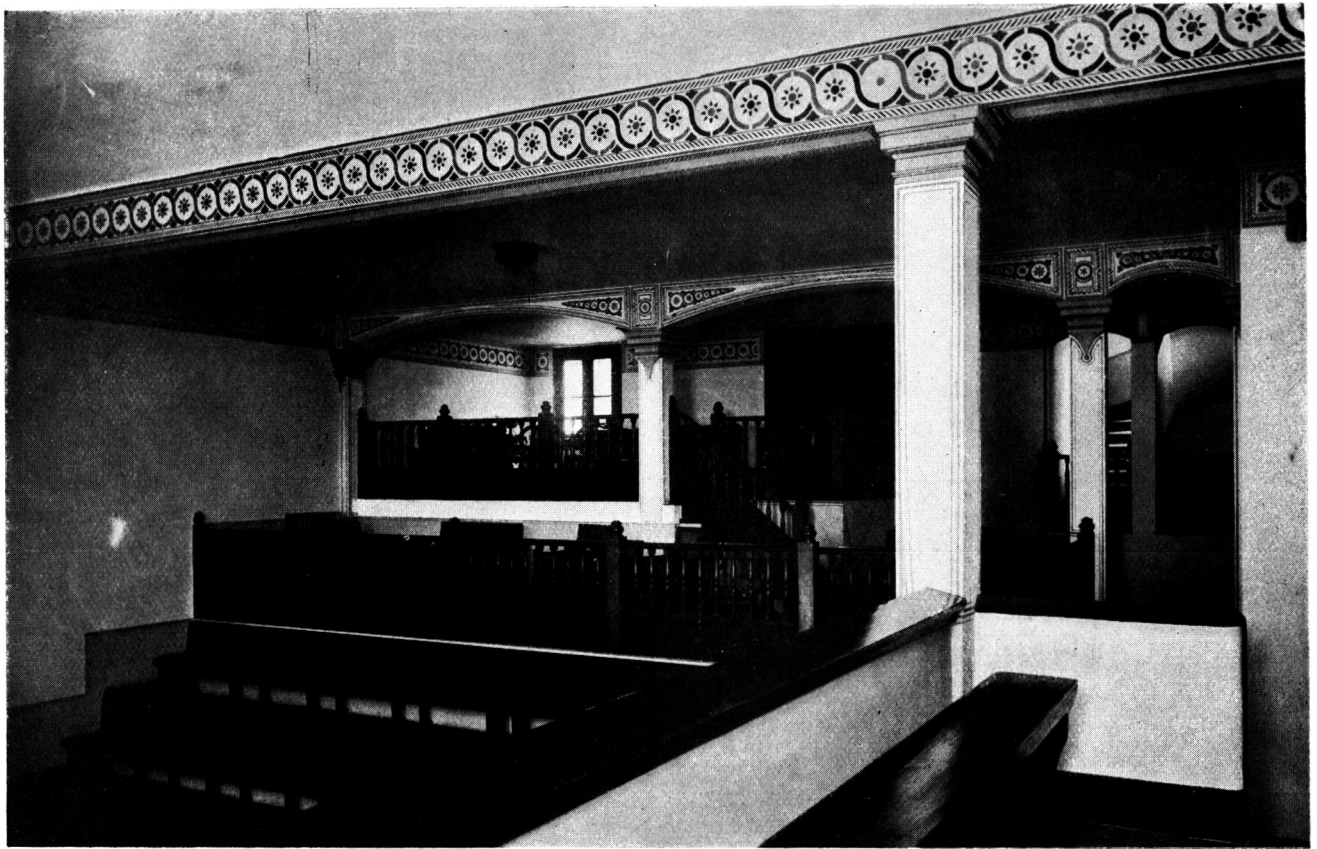
CLUB ARGENTINO DE PELOTA: VISTA DE LAS GRADAS
