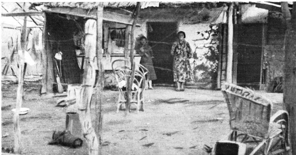
Foto N° 1. — Resistencia (Gob. del Chaco). — Interior de vivienda de barro «estanteado» con revoque de cal, techo de paja. En el barrio de la fábrica Fabril y Financiera.
