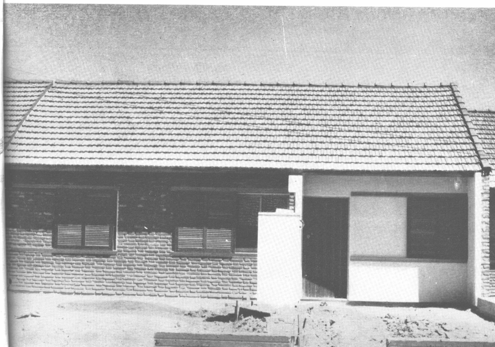
Unidades tipo Z3, de 3 dormitorios. Se construyen 125 unidades, con una superficie cubierta de 76,36 m 2 por cada una.
