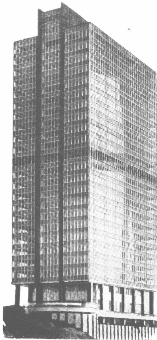
Vista de la torre Guinness, en cuyos cerramientos sismorresistentes tuvo importante papel el uso de neopreno.
