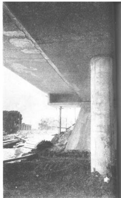
1: Detalle de la luz lateral entre la columna y el falso estribo, que están separadas 12 metros en el puente principal.
