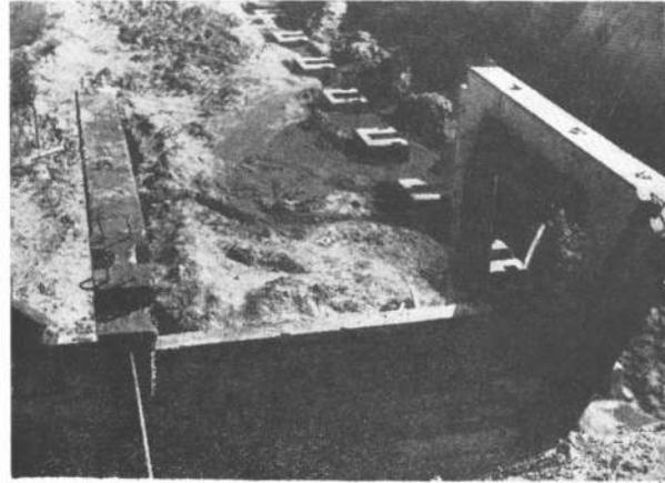
rectángulo; sus ángulos rectos —los únicos que no están en contacto con la tierra— se unen con una viga continua de hormigón in situ.
