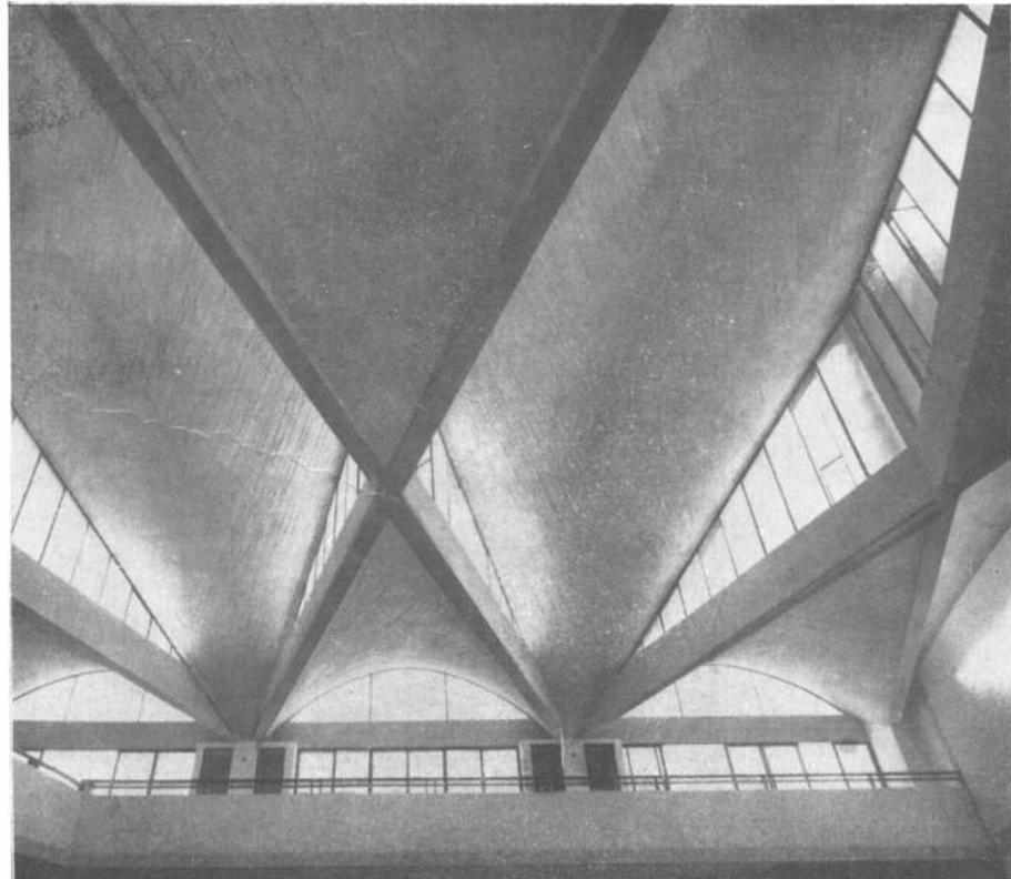
Espesor de la lámina: 6 centímetros.
