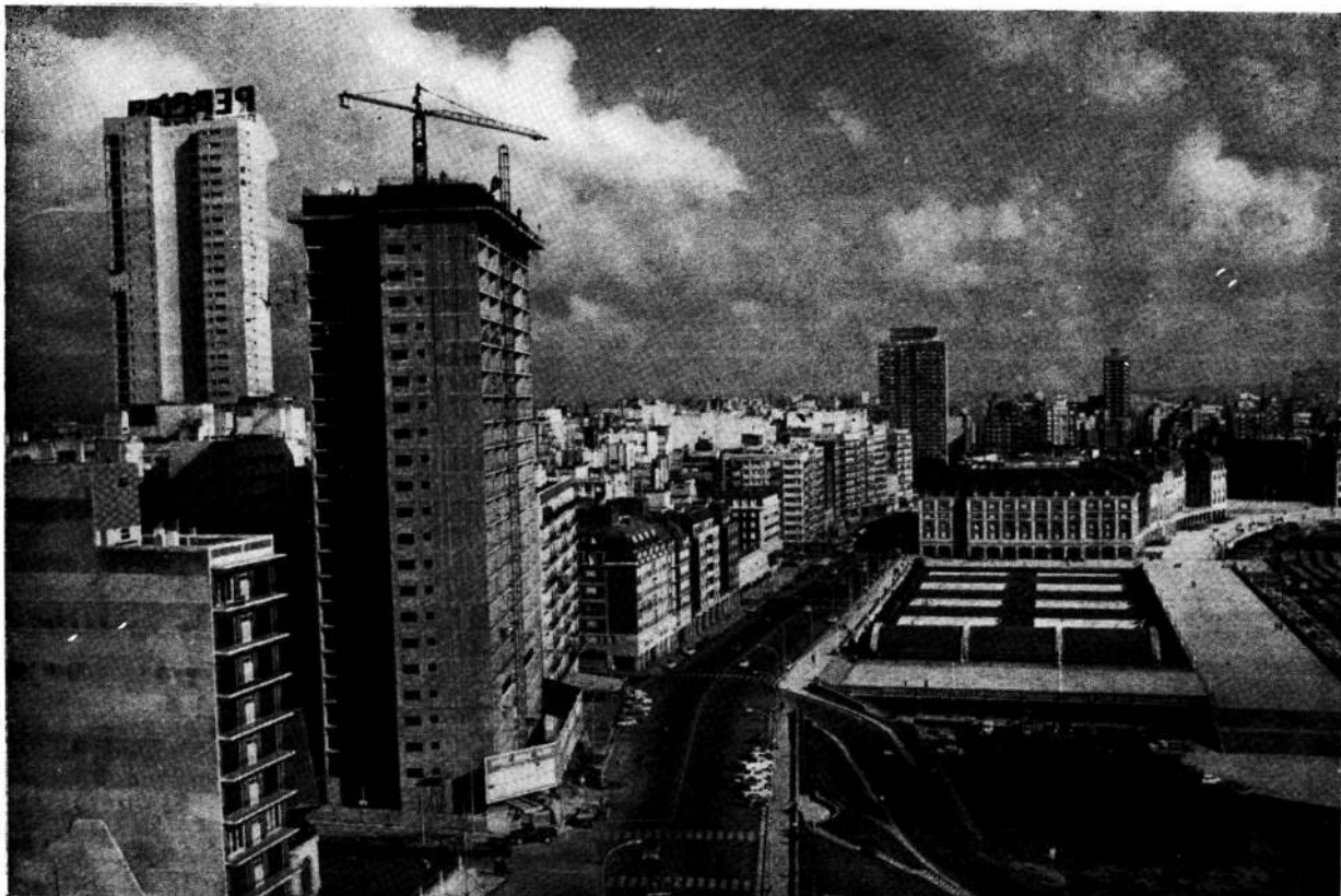
En el perfil marplatense se va pronunciando la nueva silueta del edificio Eliades. La fotografía fue tomada cuando faltan quince plantas.
