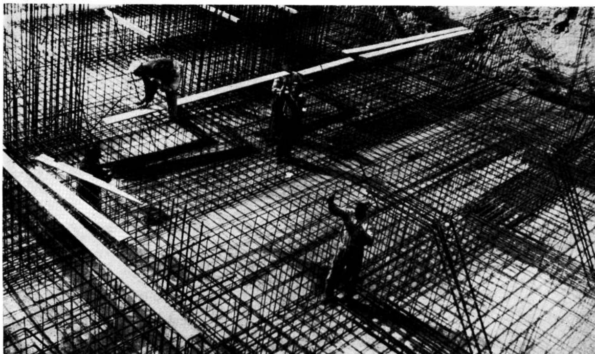
La platea de fundación tiene más de 1.000 m. cuadrados y su espesor es de un metro, doble armada. Se usaron 63 T de acero Rippentor.
