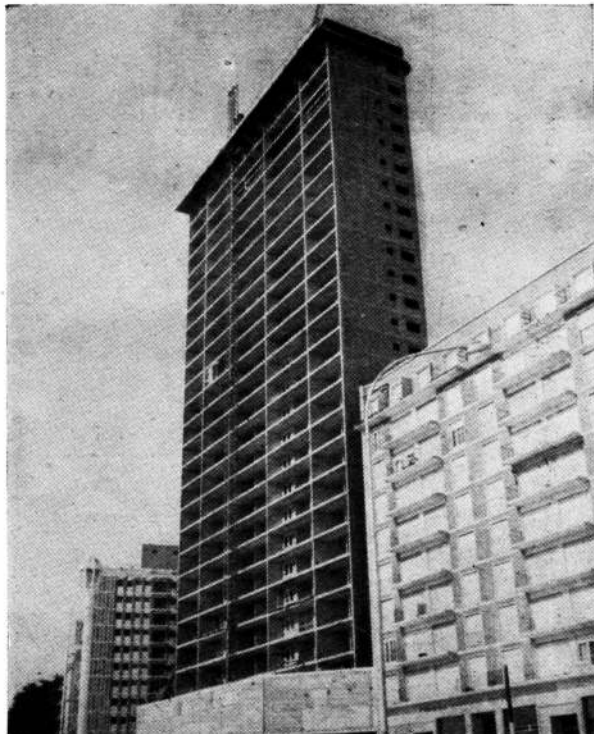
Foto reciente, tomada cuando se construía el piso veintisiete.
